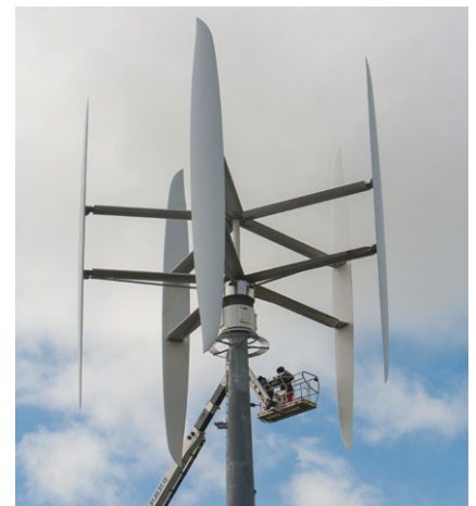
Montage einer Envergate Windturbine Quinta99 in Südfrankreich.
