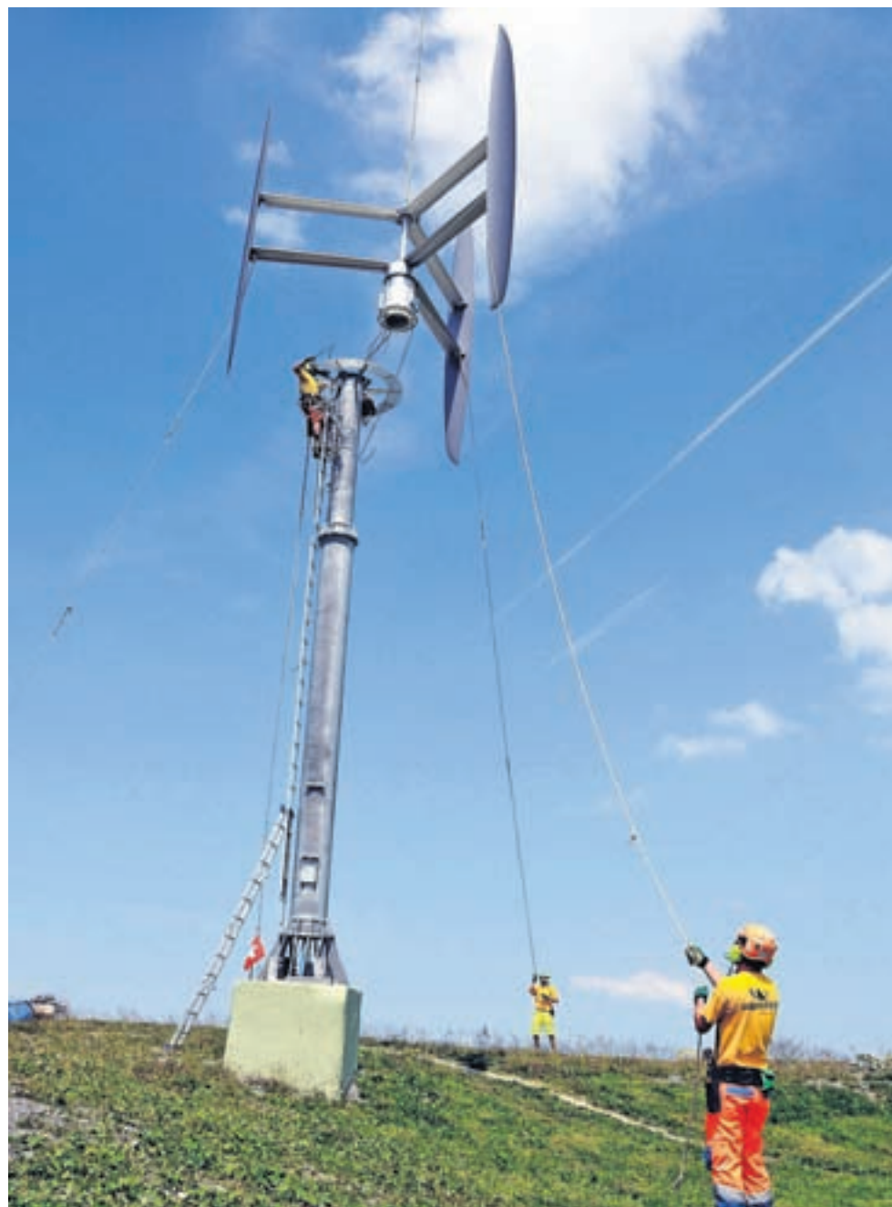
Präzisions- und Teamarbeit: Die Bodencrew platziert das Windrad, das noch am Helikopter hängt, auf dem Masten.
